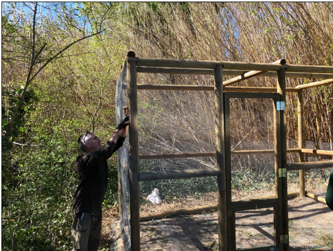
Construcció de les instal·lacions d'alliberament de trenques en el Parc Natural dels Aiguamolls de l'Empordà pel personal del Parc.
